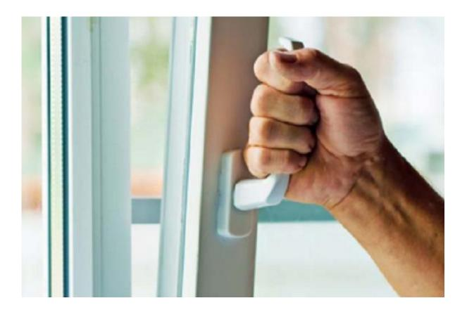
Это функция, предусмотренная конструкцией окна. Достаточно ручку установить в верхнее положение, и створка отойдёт на небольшое расстояние для свободного доступа воздуха с улицы.
