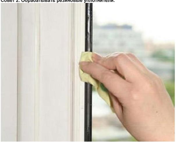
Полоски резины, укреплённые по периметру окна, создают герметичность створке. Они подвержены повышенному износу. Чтобы дольше сохранялись резиновые уплотнители, за ними необходимо ухаживать: протирать и смазывать. Качество очистки значительно улучшится, эластичность резины повысится после использования силиконового масла.
